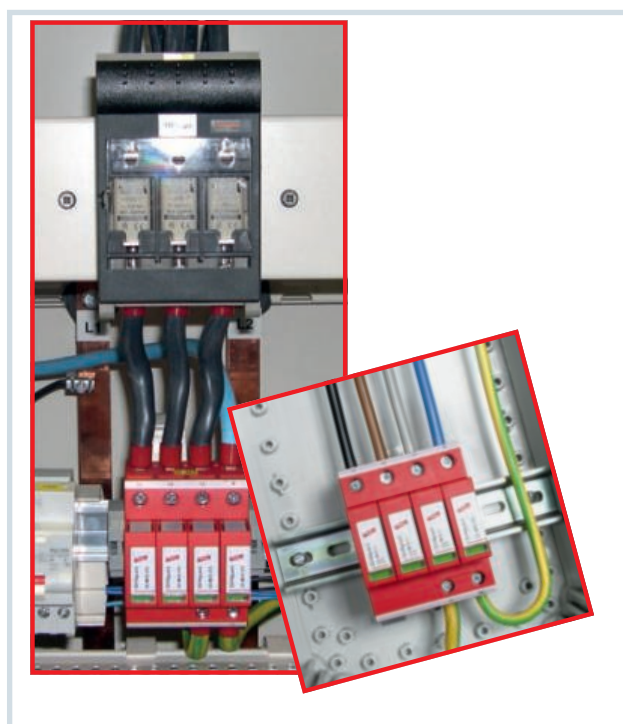
Rys. 1. Wyraźnie mniejsze zapotrzebowanie na miejsce – porównanie warunków montażu tradycyjnego ogranicznika typu 2 i ogranicznika DEHNGUARD® M/S Ci.
