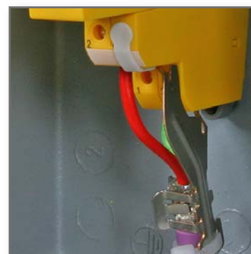
Rys. 8. Złączka sprężysta EMV SAK BXT LR zapewnia trwałe, niskimpedancyjne połączenie ekranu i jego ciągłość na odcinku przed i za ogranicznikiem BXT
