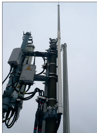
Rys. 4. Przykład zastosowanie przewodu HVI do ochrony anteny GSM zainstalowanej na stalowym maszcie antenowym
