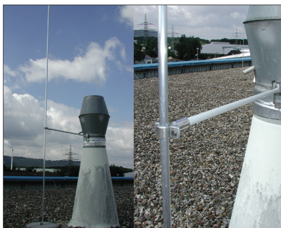
Fot. 3 Wykorzystanie elementów izolacyjnych
