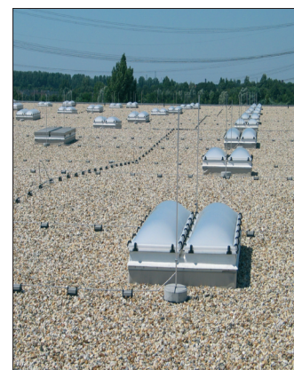
Fot. 4 Ochrona odgromowa za pomocą zwodów pionowych
