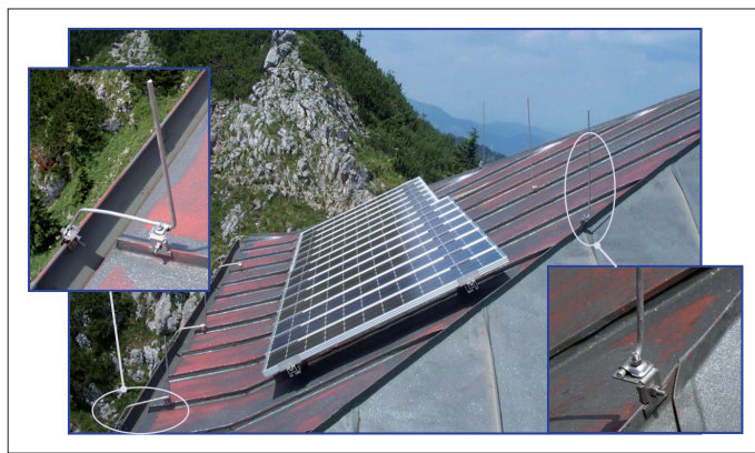
Fot. 3. Przykład montażu paneli PV na dachu z metalowym pokryciem
