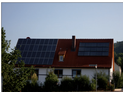
Fot. 1. Budynek jednorodzinny z panelami solarnymi i ogniwami fotowoltaicznymi na dachu
