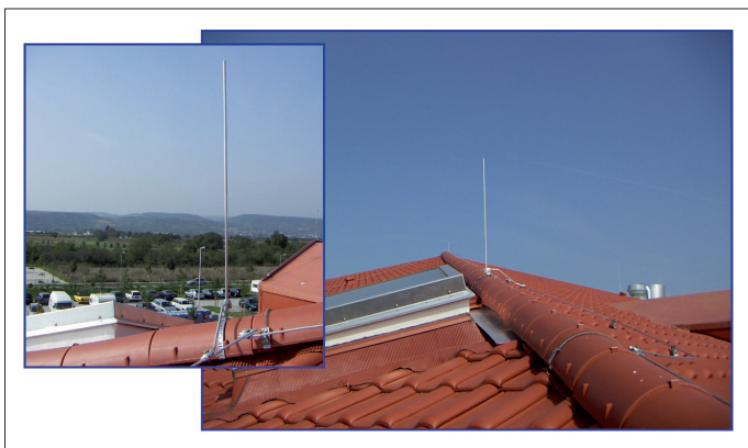
Fot. 2. Przykładowy montaż zwodu na kalenicy
