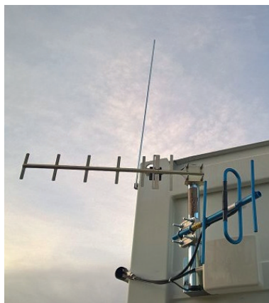
Rys. 6. Kontenerowy magazyn energii firmy VARTA GmbH – widoczny zwód pionowy w narożniku kontenera
