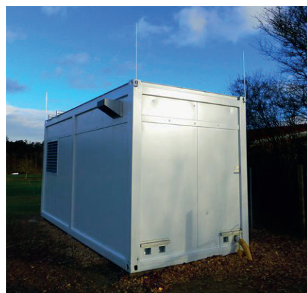
Rys. 6. Kontenerowy magazyn energii firmy VARTA GmbH – widoczny zwód pionowy w narożniku kontenera
