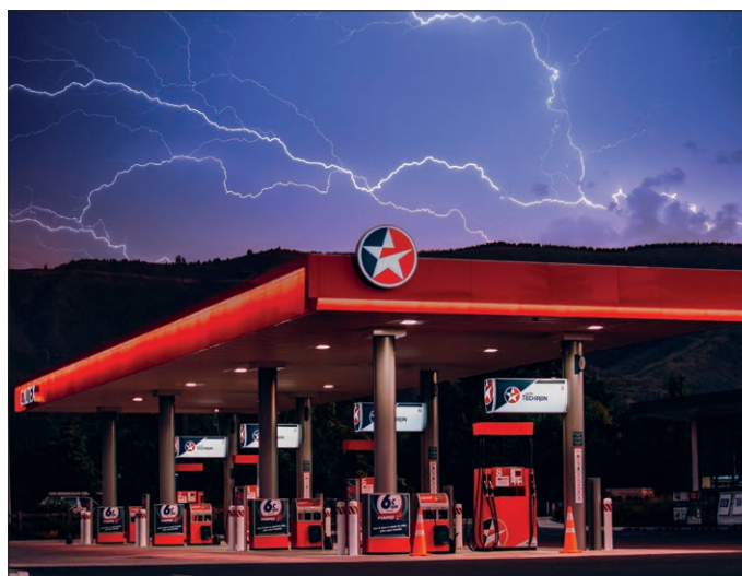
Rys. 1. Stacje paliw to obiekty, które szczególnie wymagają ochrony odgromowej i przepięciowej
