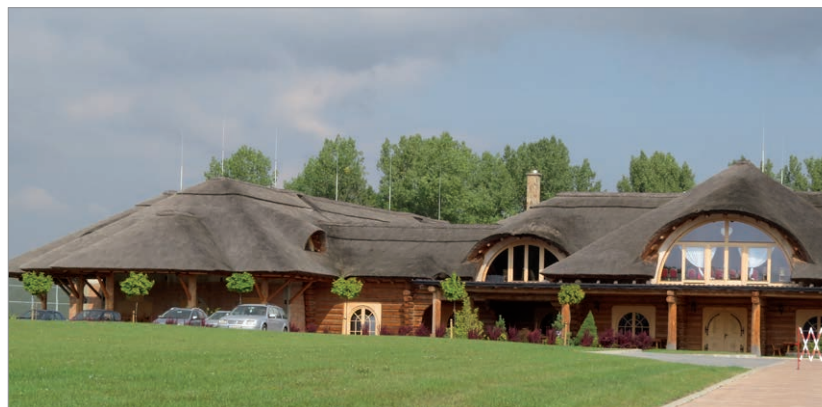
Rys. 7. Przykład zastosowania przewodu HVI light w obiekcie hotelowo-gastronomicznym
