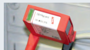
Bezpośrednie podłączenie modułu ochronnego DEHNguard
