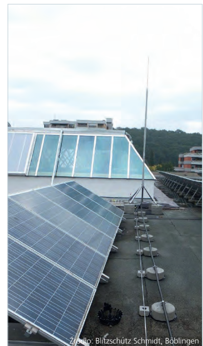
Źródło: Blitzschutz Schmidt, Böblingen
