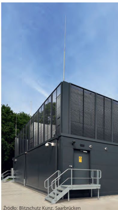
Źródło: Blitzschutz Kunz, Saarbrücken
