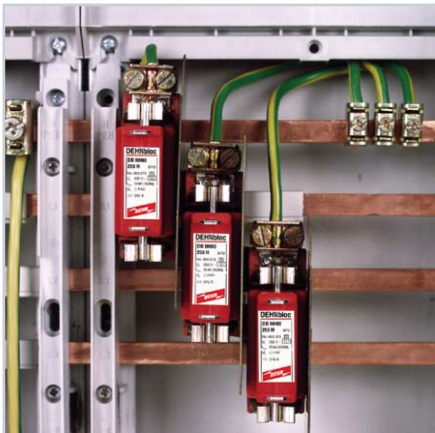
Rys. 7. Montaż ograniczników DB NH00 255H bezpośrednio na szynach zbiorczych
