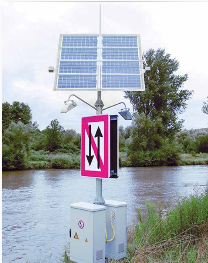
Rys. 1. Autonomiczny układ zasilania instalacji fotowoltaicznej nad brzegiem rzeki
