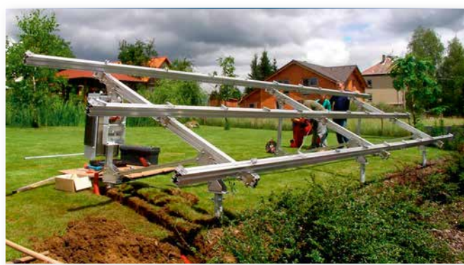
Rys. 5. Przykład montażu stelaży pod panele PV na fundamencie typu śrubowego
