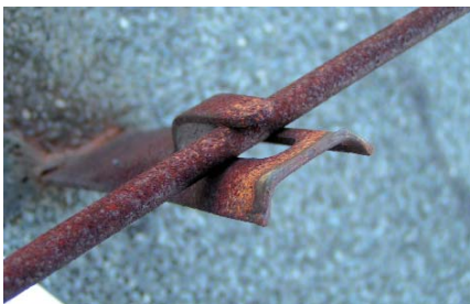
Rys. 1. Zaniedbane elementy instalacji odgromowej na dachach obiekt6w budowlanych
