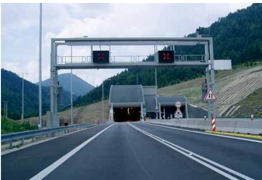
Rys. 1. Wjazd do tunelu Branisko
