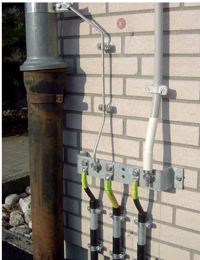
Rys. 3. Podłączenie przewodu HVI do szyny wyrównawczej
