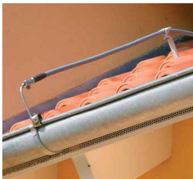
Rys. 6. Podłączenie przewodu HVI do rynny
