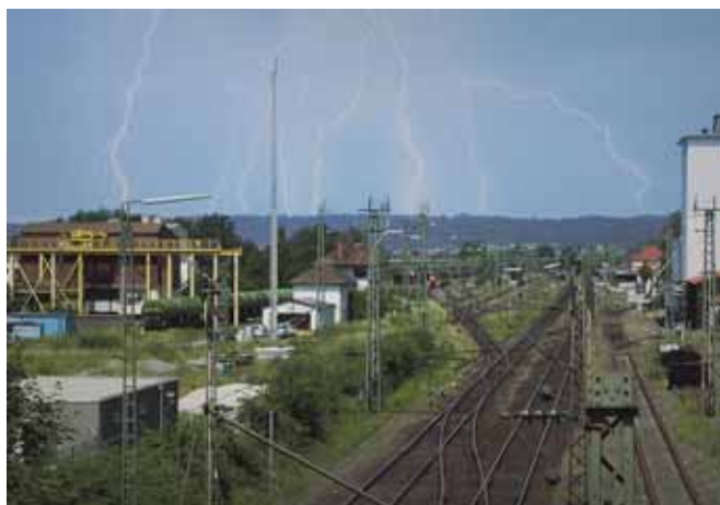
Rys. 2. Burza z piorunami stanowi zagrożenie także dla infrastruktury kolejowej
