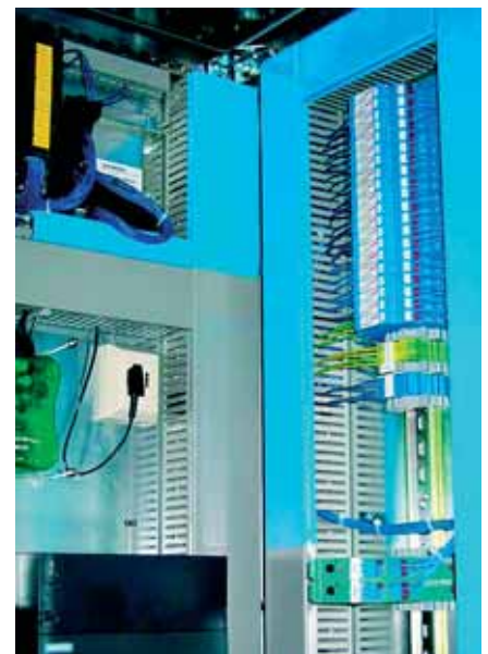
Rys. 5 Widok zamontowanych Blitzductor CT MD EX
