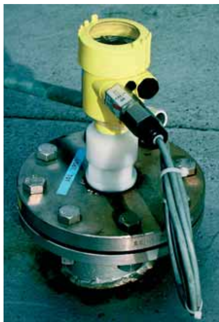
Rys. 10. DEHNpipe MD EX zamontowany na przetworniku
