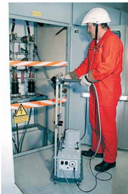
Rys. 6. Praca z urządzeniem do uzupełniania syciwa w głowicach kablowych pod napięciem
