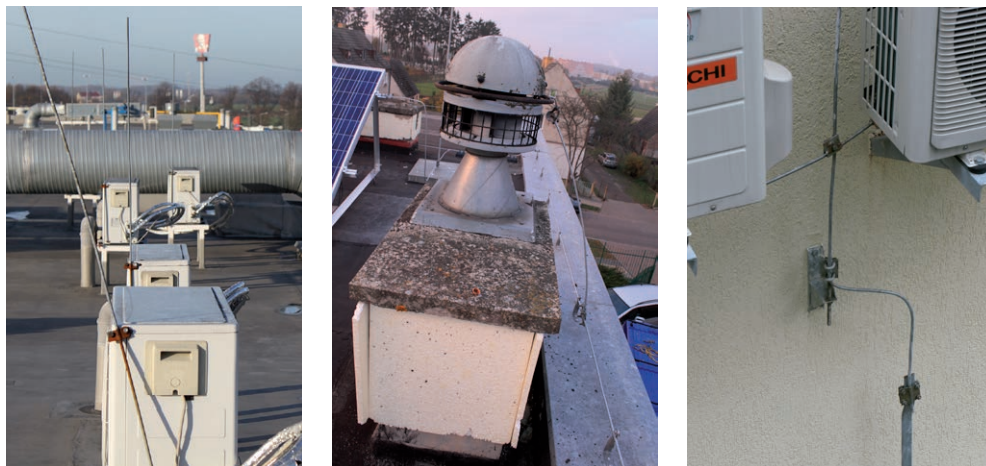
Rys. 3. Połączenie bezpośrednie urządzeń elektrycznych z elementami LPS – możliwość wniknięcia części prądu pioruna do instalacji we wnętrzu obiektu.
