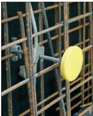
Fot. 2. Wypust uziemiający podłączony do zbrojenia przed zalaniem betonem
