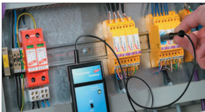
Fot. 4 Badanie ograniczników z wykorzystaniem systemu LifeCheck
