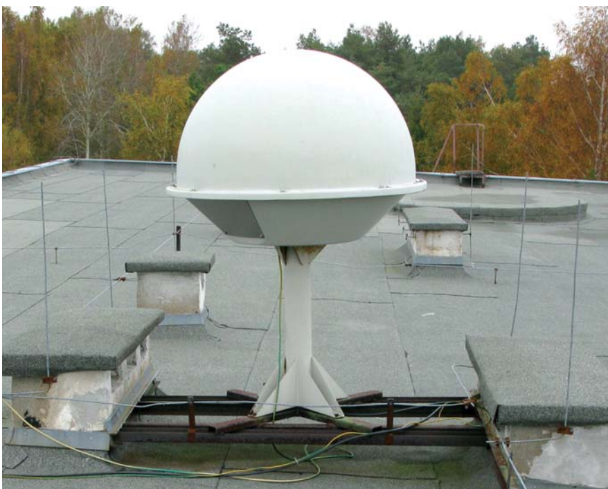
Rys. 1. Przykład błędnego rozmieszczenia zwodów pionowych na dachu budynku
