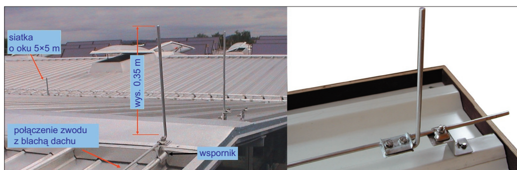
Fot. 4. Ochrona dachów za pomocą zwodów pionowych
