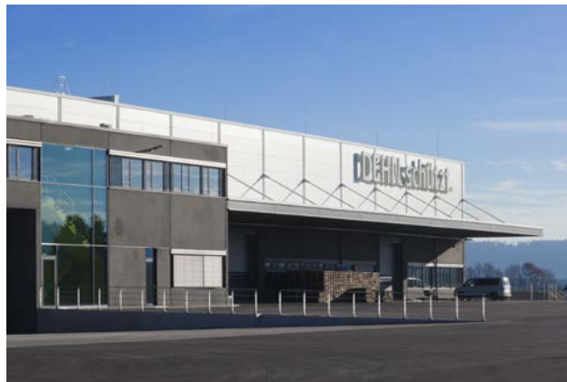
Obiekty handlowe i przemysłowe
