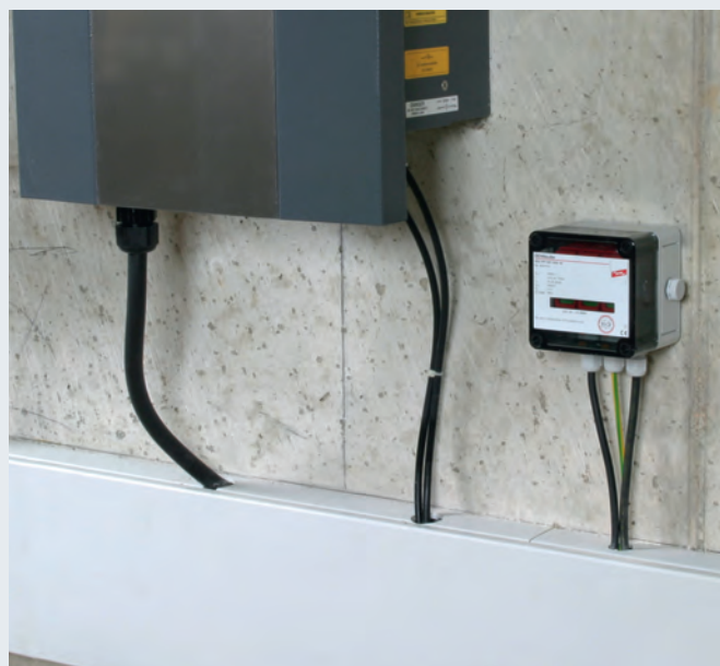
Do ochrony falowników PV przed przepięciami. Do stosowania zgodnie z normą PN-HD 60364-7-712 „Wymagania dotyczące specjalnych instalacji lub lokalizacji. Fotowoltaiczne (PV) układy zasilania”
