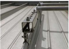
Der Metalldachhalter öffnet neue Wege bei der Installation des äußeren Blitzschutzes, da er höchste Flexibilität in einem breiten Einsatzspektrum ermöglicht. Ob zur Errichtung von HVI Blitzschutzsystemen bei Schräg-/Tonnendächern oder zur Montage konventioneller Fangstangen für den Schutz von Metalldächern vor direktem Einschlag, mit dem blitzstromgeprüften Metalldachhalter steht für unterschiedlichste Anwendungsfälle eine passende Lösung zur Verfügung.
