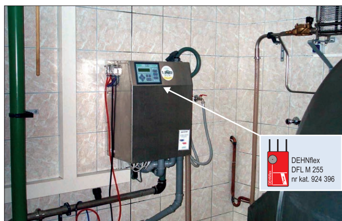
Rys. 3. Elektronicznie sterowana instalacja przewietrzania i splukiwania
