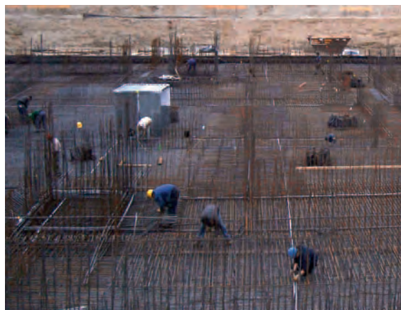
Rys. 5.5.2.6 Uziom fundamentowy o strukturze sieciowej
