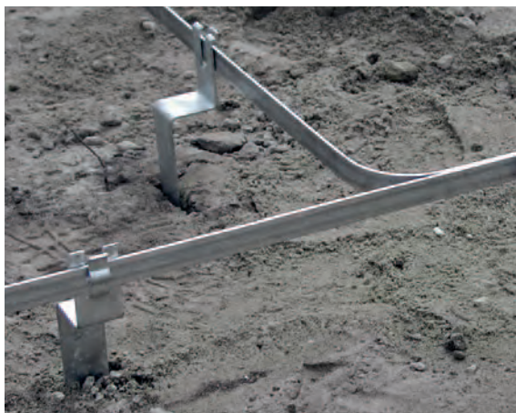
Rys. 5.5.2.3 Uziom fundamentowy
