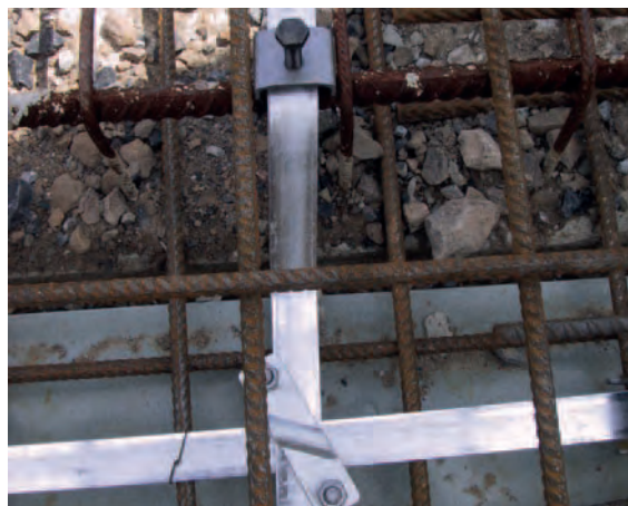
Rys. 5.5.2.4 Zastosowanie uziomu fundamentowego
