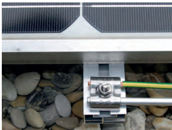
Rys. 9.18.3 Zacisk uziemiający UNI: element pośredni ze stali nierdzewnej pozwala uniknąć korozji, dzięki czemu tworzy się niezawodne wieloletnie połączenie między różnymi materiałami przewodzącymi
