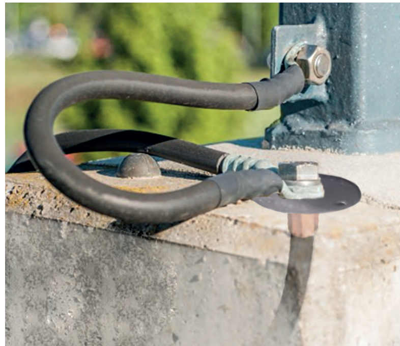
Rys. 3. Łącznik uziemiający
