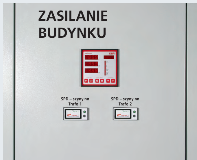
Optyczne wskaźniki do ograniczników przepięć do zabudowy na drzwiach szafy rozdzielczej
