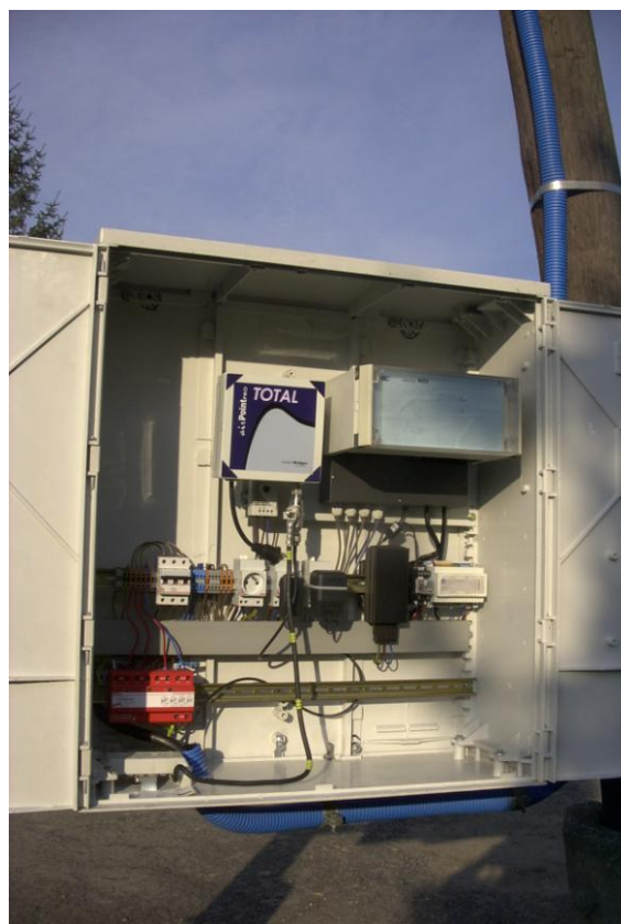
Rys. 12. Ochrona odgromowa i przepięciowa koncentratora, a) ochrona anten przed bezpośrednim uderzeniem piorunu, b) urządzenia ograniczające przepięcia
