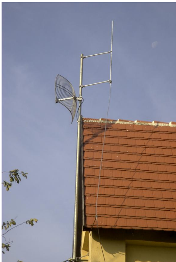
Rys. 12. Ochrona odgromowa i przepięciowa koncentratora, a) ochrona anten przed bezpośrednim uderzeniem piorunu, b) urządzenia ograniczające przepięcia
