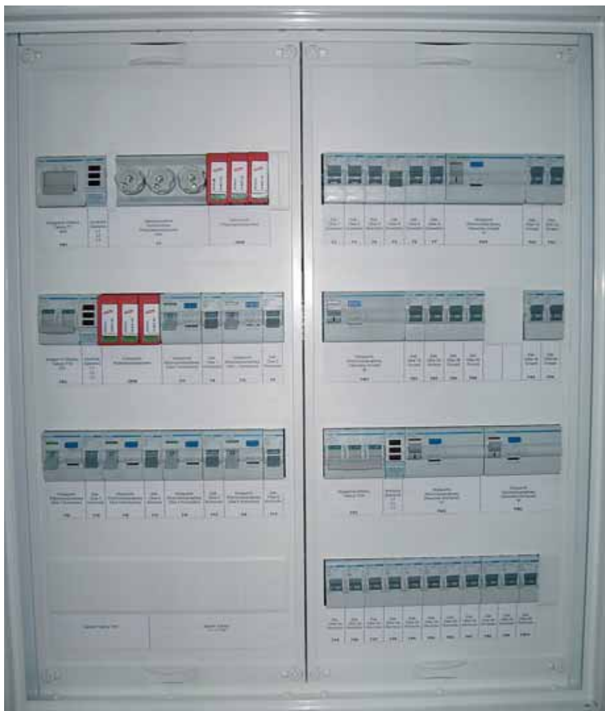
Rys. 8. Przykładowa instalacja z ogranicznikami DEHNrail 255 modular
