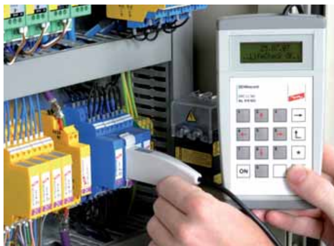
Rys. 4. Badanie z wykorzystaniem miernika DRC LC M3
