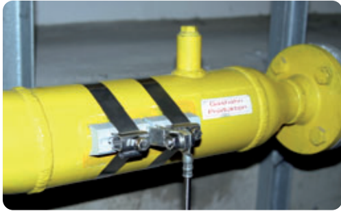
Bandrohrschelle zur elektrisch sicheren Kontaktierung von Rohren im Ex-Bereich, zur Umsetzung des Blitzschutz-Potentialausgleichs nach DIN EN 62305-3 (VDE 0185-305-3)
