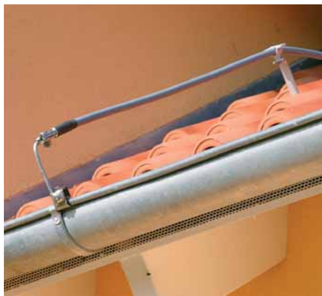
Rys. 6. Podłączenie przewodu HVI do rynny
